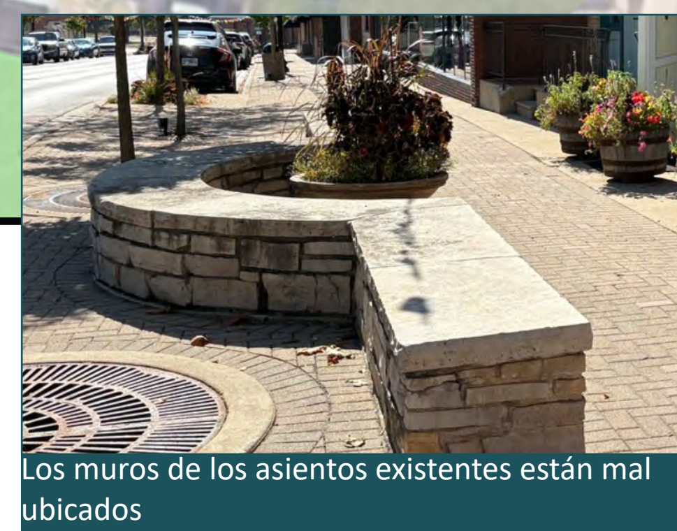
Los adoquines de hormigón se están agrietando, asentando y están mal alineados
